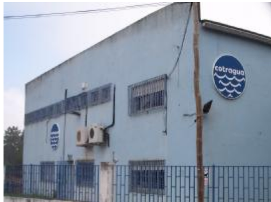
Ilustración 1: Exterior de talleres y oficinas de COTRAGUA, S.L. en Mos (Pontevedra - GALICIA)
