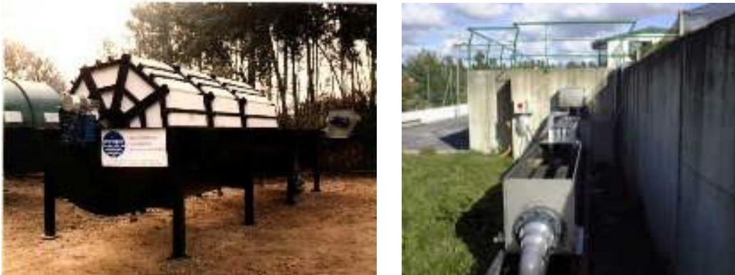
Ilustración 5: Detalle de Biodiscos y Desinfección mediante rayos UV
